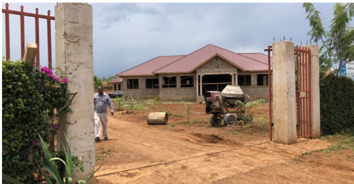
Regntiden stod for døren og det hastet med å få lagt tak på de tre nye bygningene. Her skole- og admin bygget.
